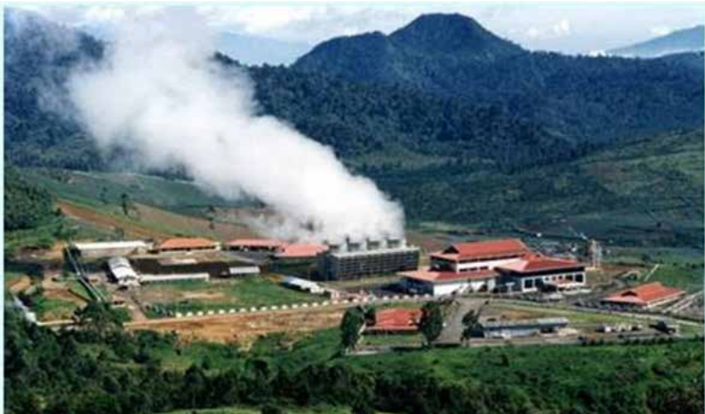
Gambar 5.14. Keadaan Kompleks Panas Bumi Darajat, Kabupaten Garut setelah selesainya peningkatan Unit III pada tahun 2009, total kapasitas daya listrik PLTP Darajat naik dua kali lipat menjadi 271 MW, (sumber: https://www.starenergygeothermal.co.id/ )
