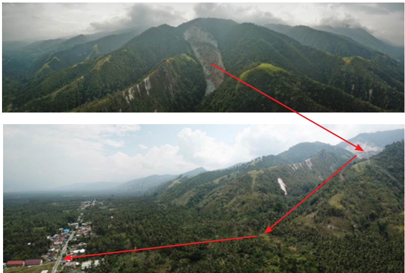
Gambar 3. Hasil pengambilan gambar dengan drone di lokasi longsor dan potensi banjir bandang desa Poi, Kecamatan Dolo Selatan
