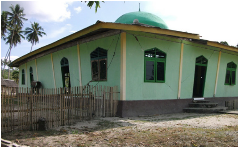
Gambar 5. Masjid di desa Lambonga, Kecamatan Balaesang, Kabupaten Donggala rusak berat akibat gempabumi tanggal 28 September 2018, terletak pada endapan aluvial pantai.
