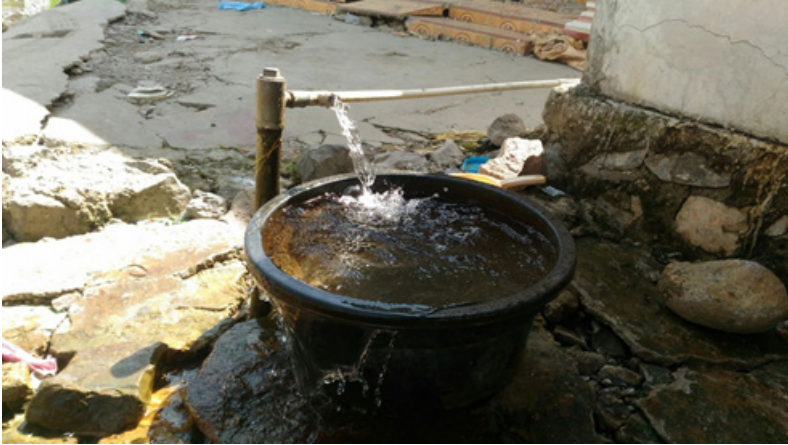
Gambar 2 . Sumber air artesis pada sumur pantek di kedalaman 6 m di bawah muka tanah
