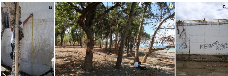
Gambar 1. Tanda air di dinding (Lero, no.9 pada tabel 1), batang tergores (Buluri, no. 29 pada Tabel 1) dan debris (Palu IV Bridge, no. 3 pada Tabel 1) menjadi penanda kedalaman aliran tsunami.
