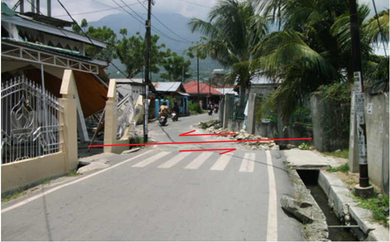
Gambar 7. Pergeseran mengiri ( sinistral offset ) sebesar 515 cm di Jalan Cemara Indah, Donggala Kodi, Kota Palu.
