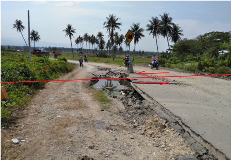
Gambar 8. Pergeseran mengiri ( sinistral offset ) sebesar 246 cm di dekat mata air daerah Marawola, Kabupaten Sigi. Terlihat pada jalan bagian kanan telah diurug.
