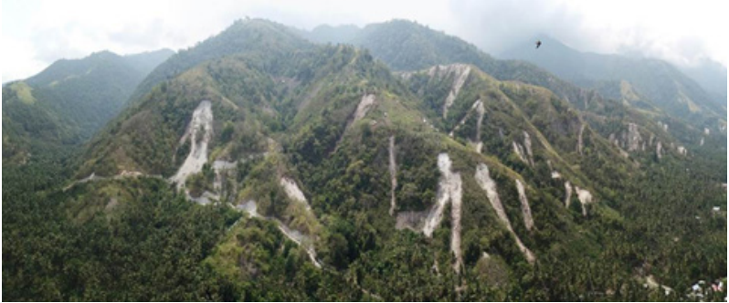
Gambar 5 Longsoran akibat gempa di sepanjang jalan di Desa Sambo dan Wisolo, kec. Dolo Selatan, Sigi.
