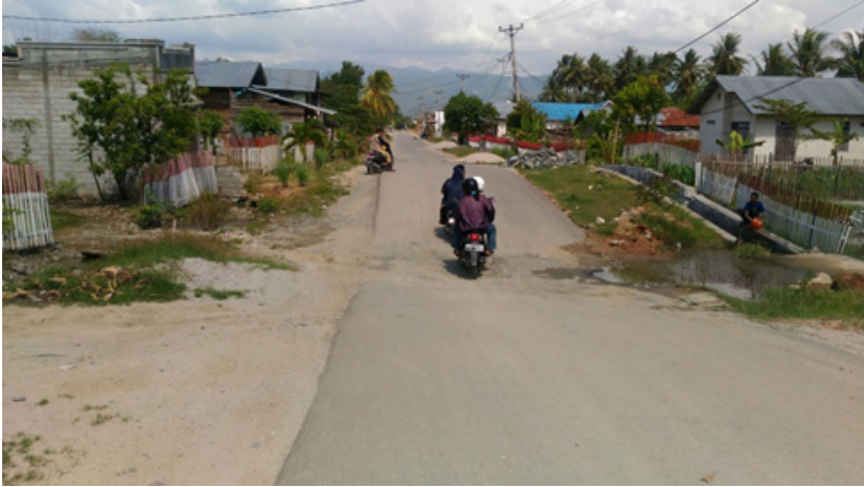
Gambar 12. Undulasi (tanah bergelombang) yang terjadi di sekitar bagian kaki (Toe) Petobo
