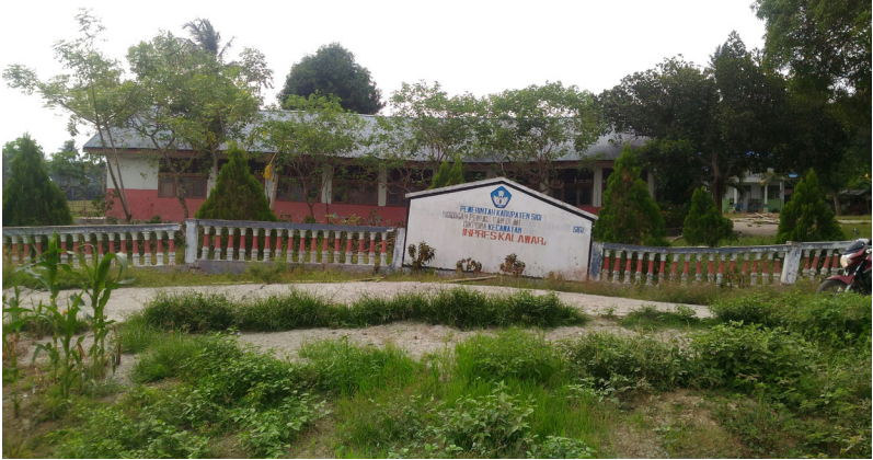
Gambar 3. Kerusakan akibat fenomena lateral spreading .
