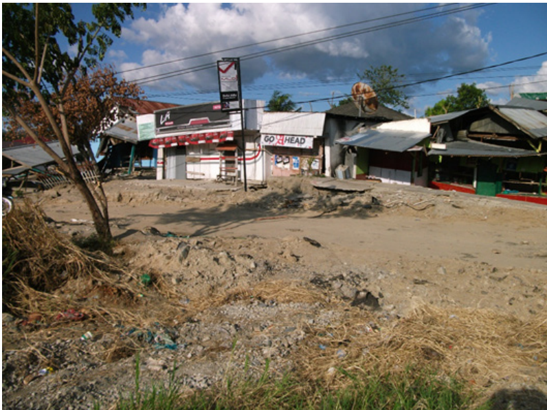
Gambar 6. Tanah bergelombang yang mengakibatkan kerusakan bangunan di daerah Jono Oge, Kecamatan Sigi Biromaru, Kabupaten Sigi akibat gempabumi 28 September 2018. Skala intensitas gempabumi di daerah Jono Oge mencapai IX MMI.
