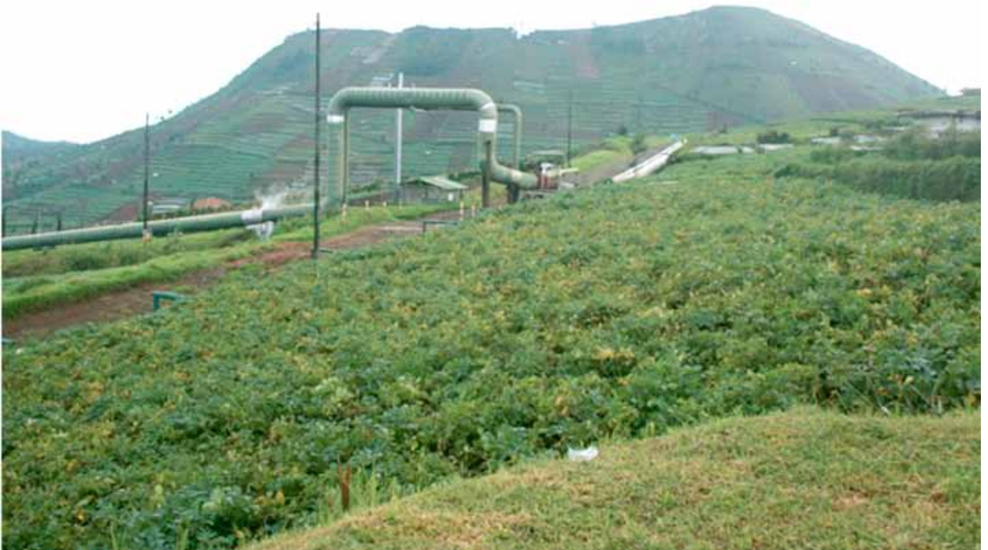
Uap panas bumi tidak memerlukan transportasi yang bergerak. Pipa besar ini menyalurkan uap dari sumur panas bumi untuk energi listrik. Lapangan Panas Bumi Dieng.
