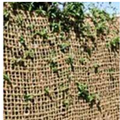
Gulungan kokomes (kiri), tebing yang sudah dipasang kokomes (tengah), dan tanaman yang sudah mulai tumbuh pada jaring-jaring kokomes yang dipasang pada sebuah dinding tebing reklamasi (kanan). Sumber: http://rumahsabat.blogspot.com/2009/07/cocomesh-jaring-sabut-kelapa.html
