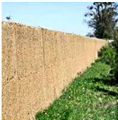
Gulungan kokomes (kiri), tebing yang sudah dipasang kokomes (tengah), dan tanaman yang sudah mulai tumbuh pada jaring-jaring kokomes yang dipasang pada sebuah dinding tebing reklamasi (kanan). Sumber: http://rumahsabat.blogspot.com/2009/07/cocomesh-jaring-sabut-kelapa.html
