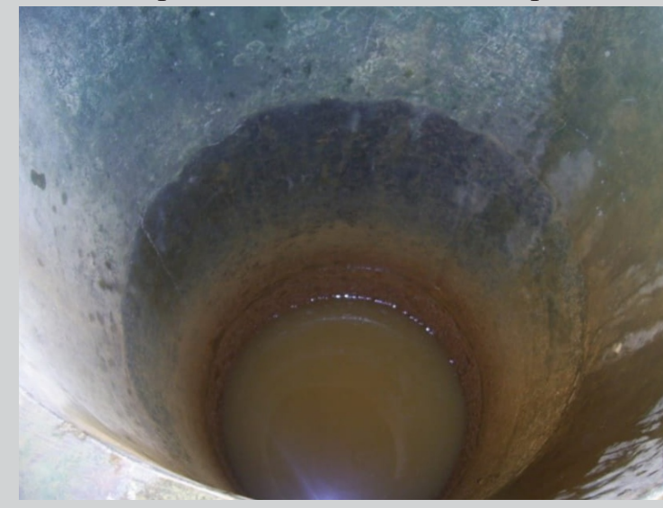
Contoh semburan pasir dan lumpur yang menyebabkan air sumur menjadi keruh akibat gempabumi Padang 30 September 2009
