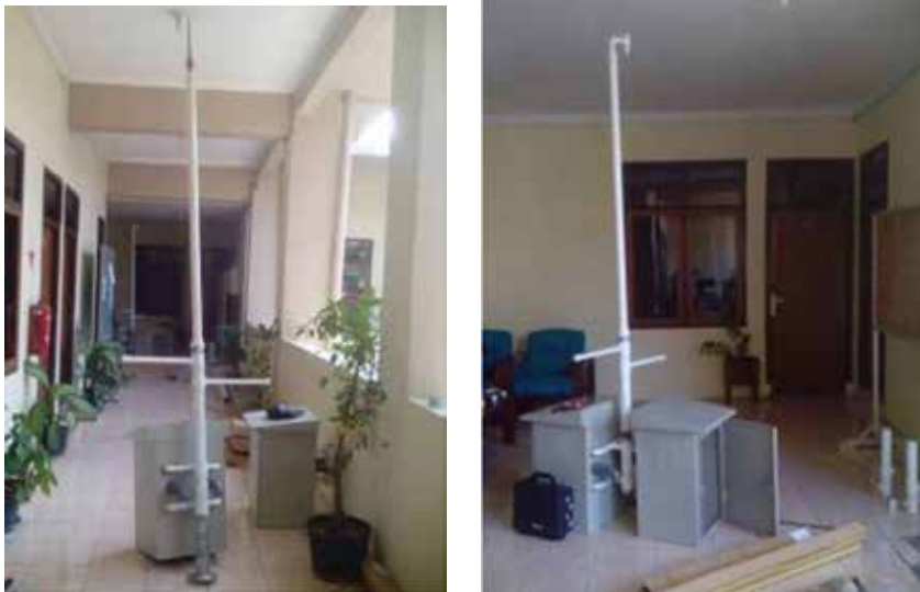
Gambar 4.174 Sebagian barang yang telah dipersiapkan untuk instalasi. (Kiri) Tiang antenna dan solar panel beserta boks panel untuk stasiun repeater. (Kanan) Tiang antenna dan solar panel beserta 2 unit boks panel untuk stasiun lapangan.
