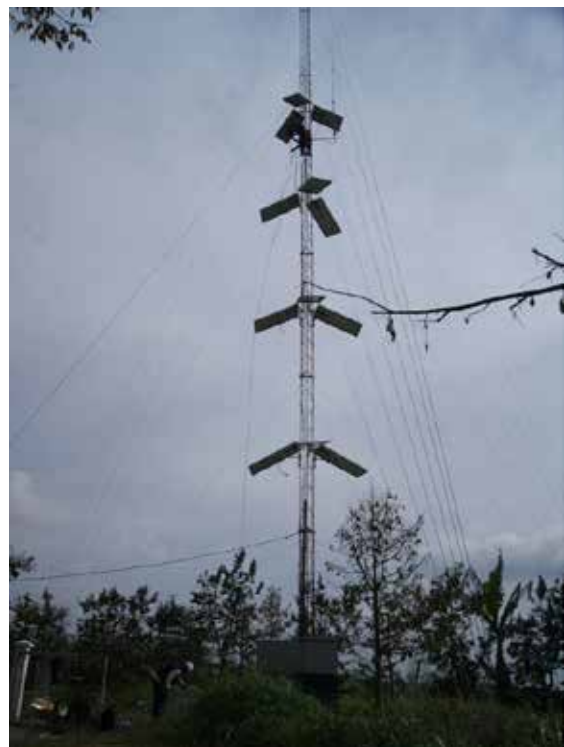
Gambar 4.191 Kondisi tower di stasiun penerima yang telah dipasang 12 unit solar panel.
