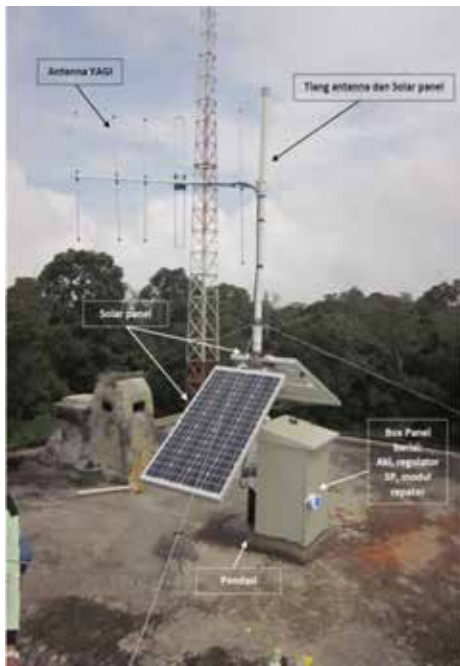
Gambar 4.178 Stasiun Repeater yang telah dibangun kembali.
