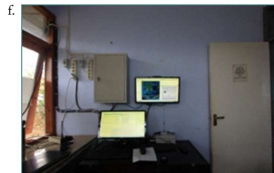
Gambar Sistem akuisisi data di stasiun penerima. a. Box panel berisi diskriminator, radio penerima, ADC PSN dan serial to Ethernet konverter. b. Komputer akuisisi data seismik. d. Komputer akuisisi data tiltmeter. e. Komputer untuk olah data. f. Modem FSK TLR sebagai penerima data Tiltmeter. f. Ruang monitoring untuk memantau aktivitas Gunung Sangeang Api.
