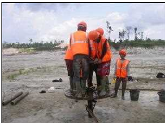
Gambar 5. Pengeboran menggunakan bor Bangka diameter 4"
