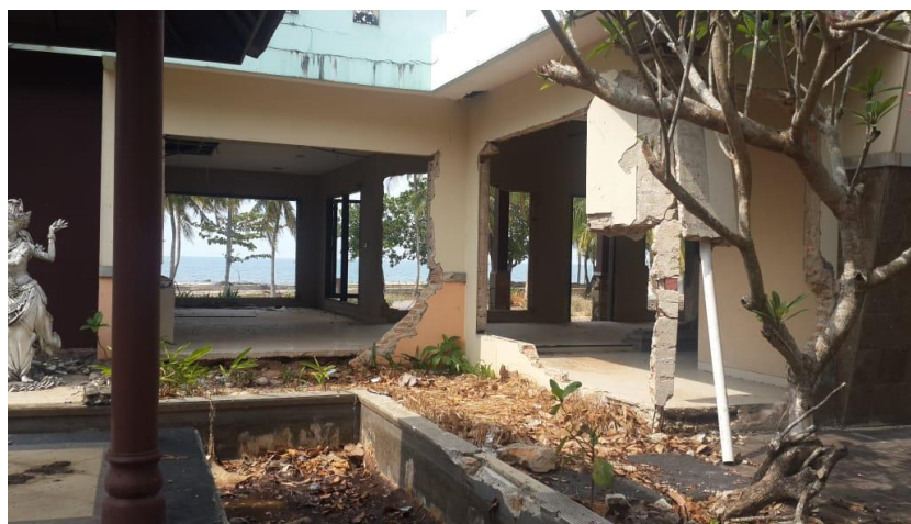
Gambar 37. Kerusakan pada bangunan hotel di Tanjung Lesung Resort, Banten oleh tsunami 22 Desember 2018 (Yudhicara et al. , 2019).
